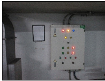
รูปที่ 19 บ่อหน่วงน้ำ และตู้ควบคุมปั้มน้ำ
