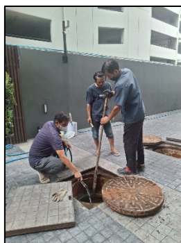
รูปที่ 18 การล้างท่อระบายน้ำรอบโครงการ
